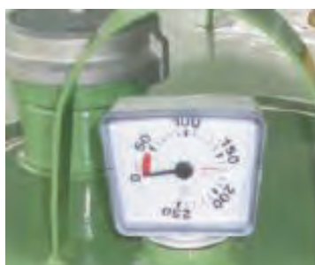
Figura 16: Esempio di indicatore del livello di riempimento del serbatoio
