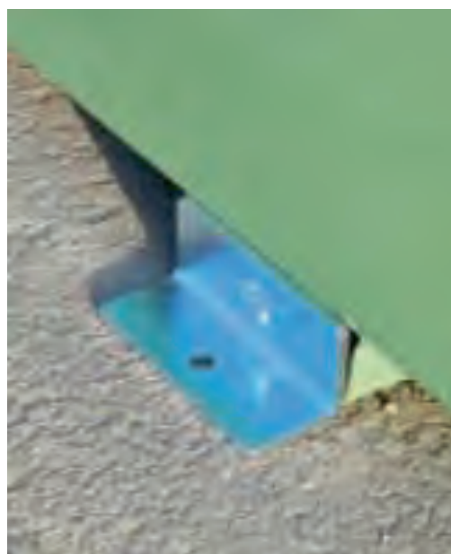
Figura 15: Zanca di ancoraggio
