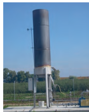
Figura 38: Torcia di emergenza (Fonte: Inail)
